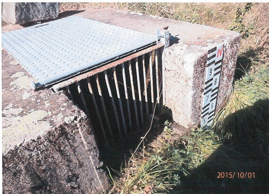
Stávající výpustné zařízení – požerák v tělesu hráze
